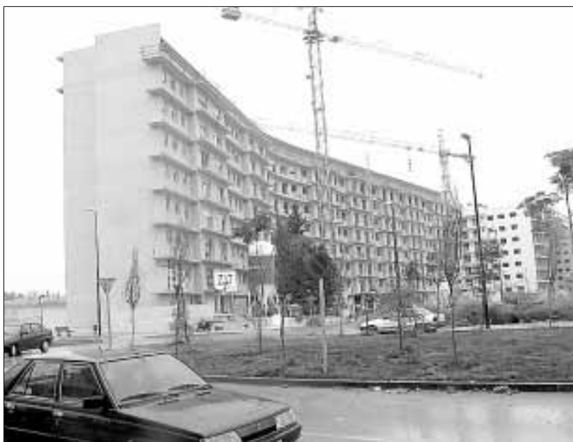
►► Construcción de un bloque de viviendas, en Zaragoza.
